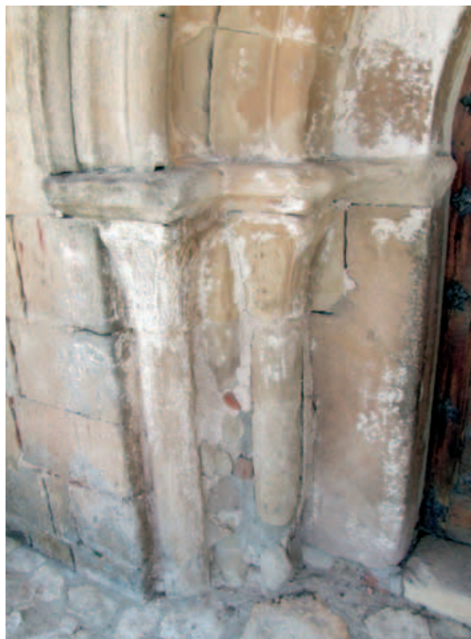
Detalles de las columnas del lado izquierdo
