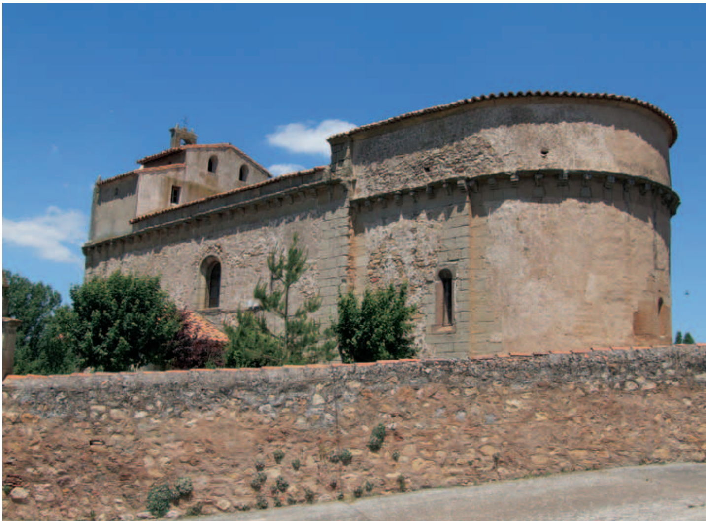
Vista general de la iglesia
