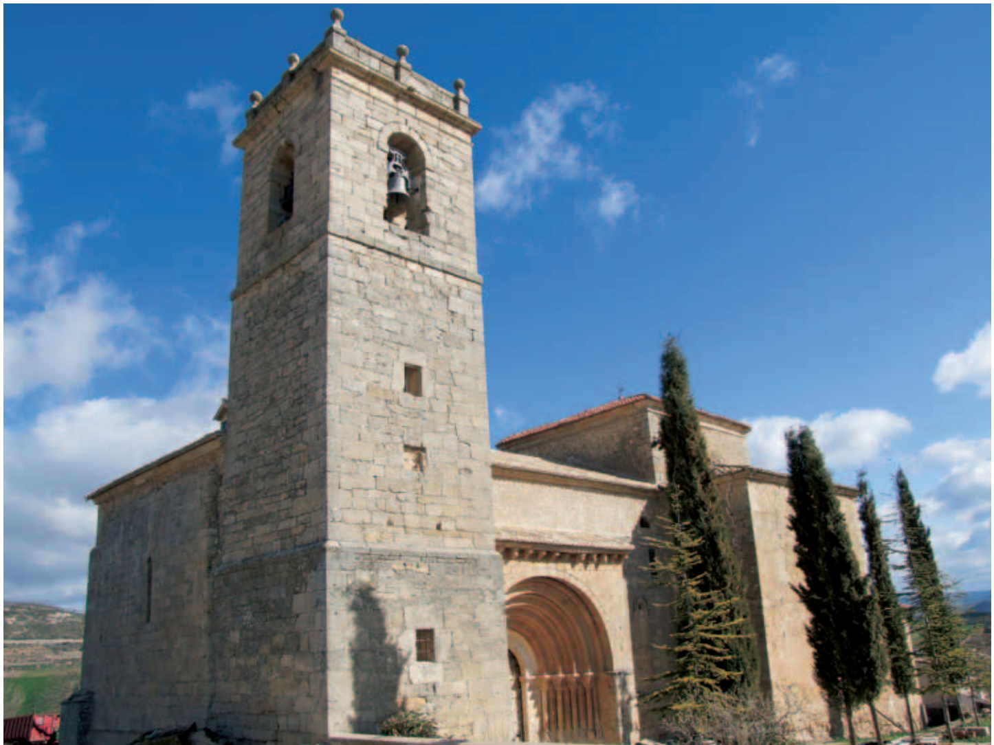
Vista exterior desde el lado sur
