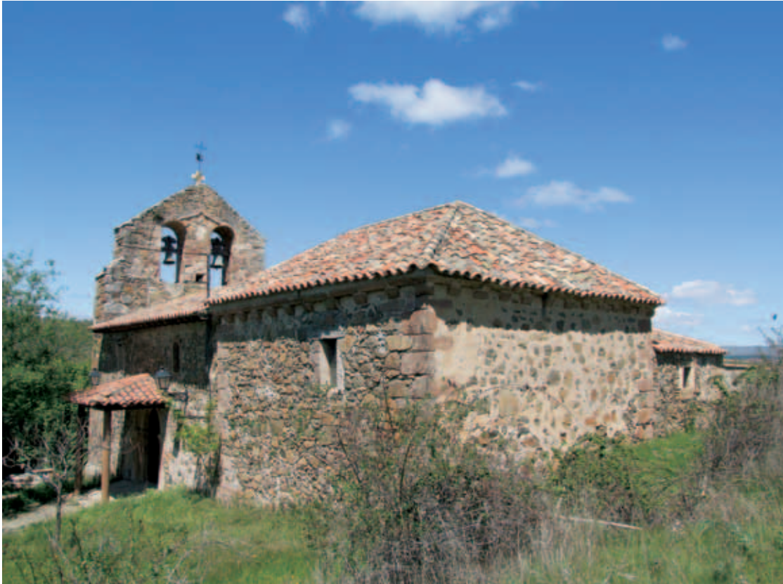
Vista sureste de la iglesia
