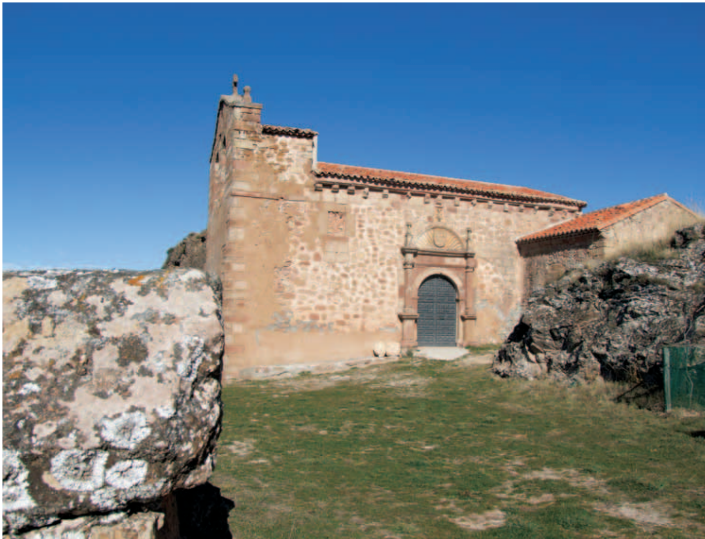
Vista del lado sur
