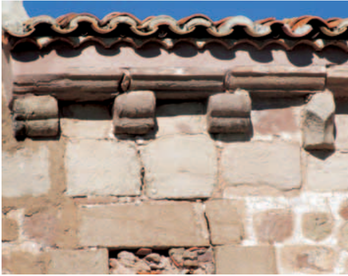
Canecillos del muro sur
