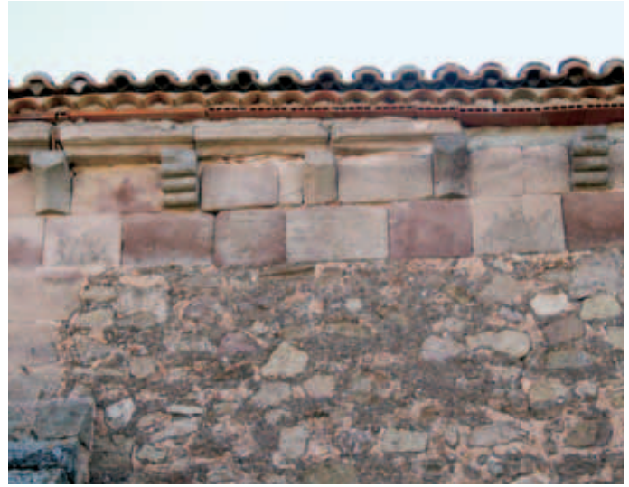
Canecillos del muro norte
