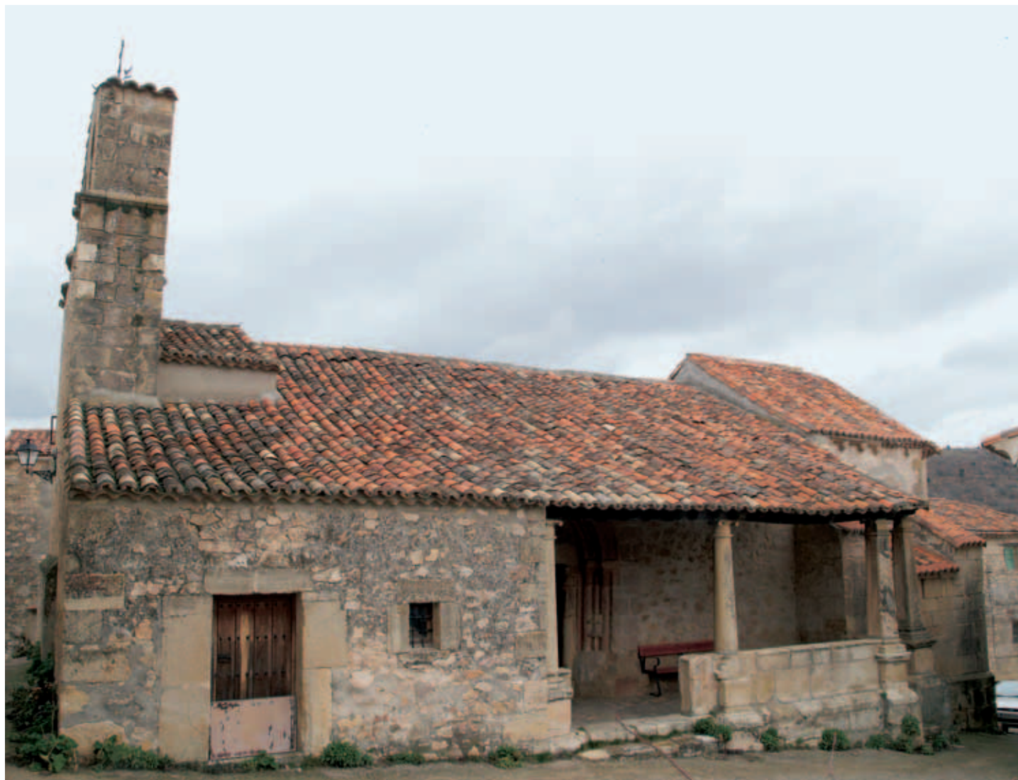
Vista general de la iglesia
