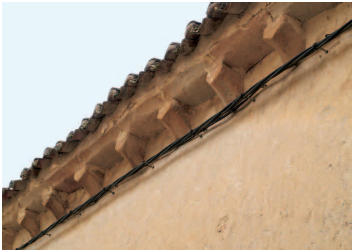
Canecillos del muro norte
