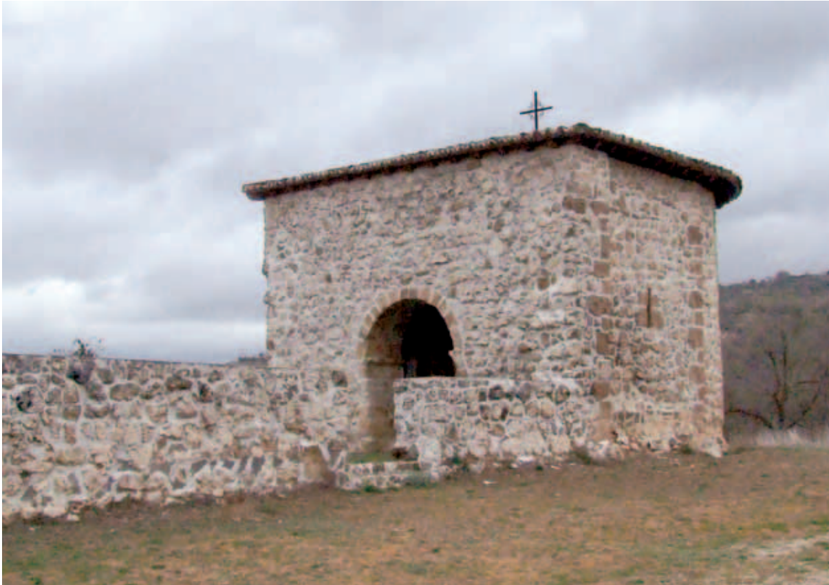
Vista desde el lado suroeste
