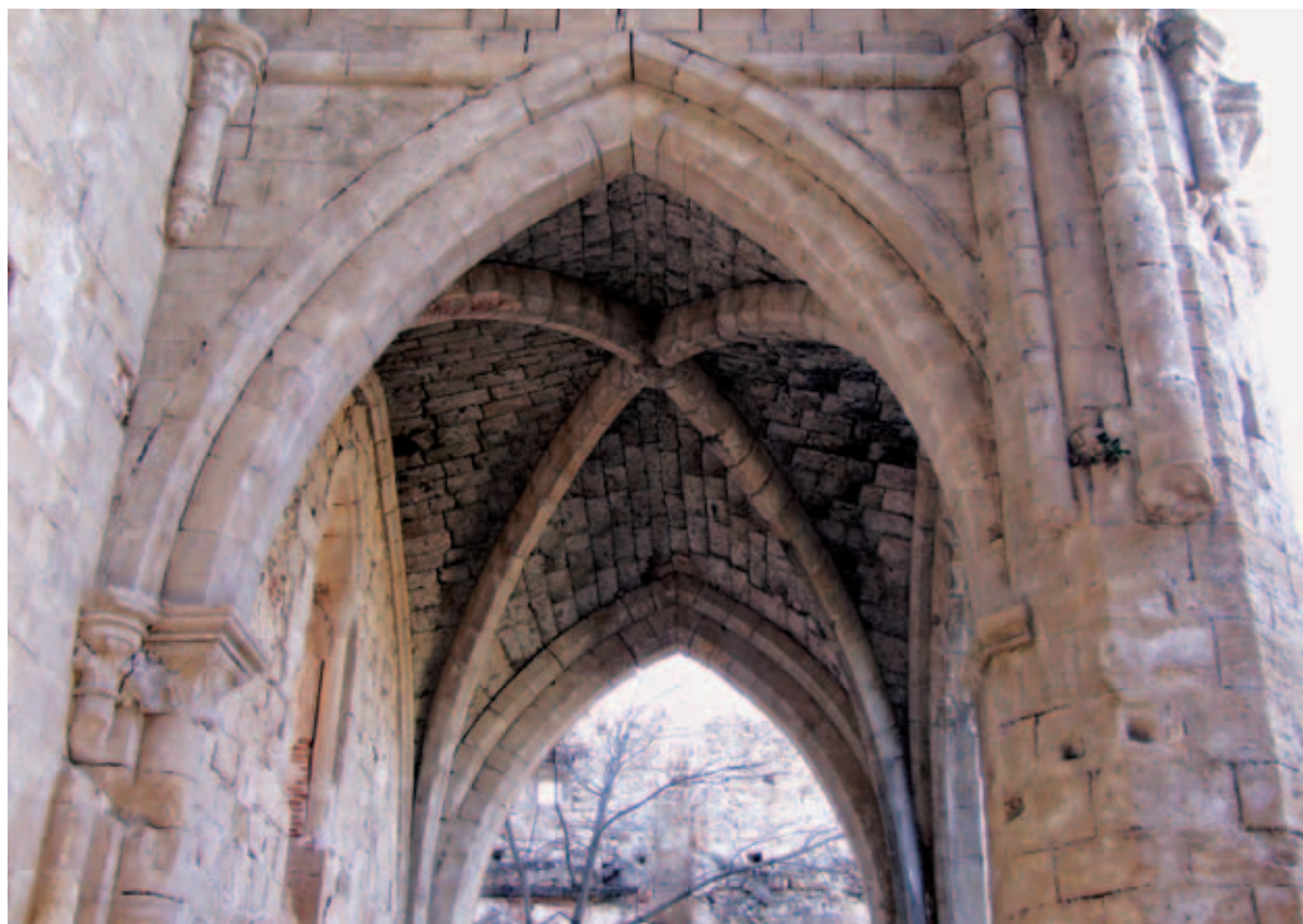
Tramo de la nave sur con bóveda de crucería
