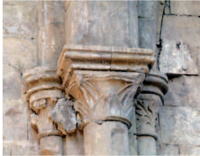
Capiteles del muro sur
