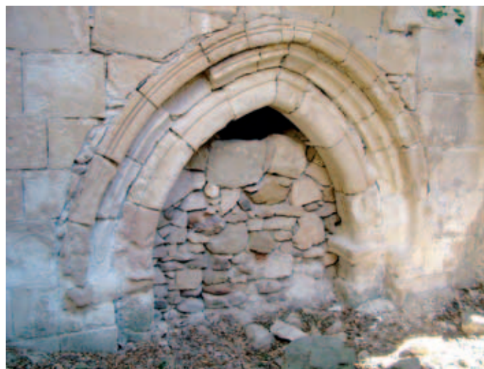
Acceso a la antigua capilla y sacristía
