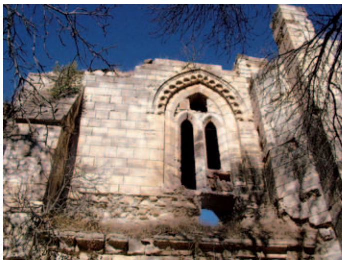
Ventanal del muro sur
