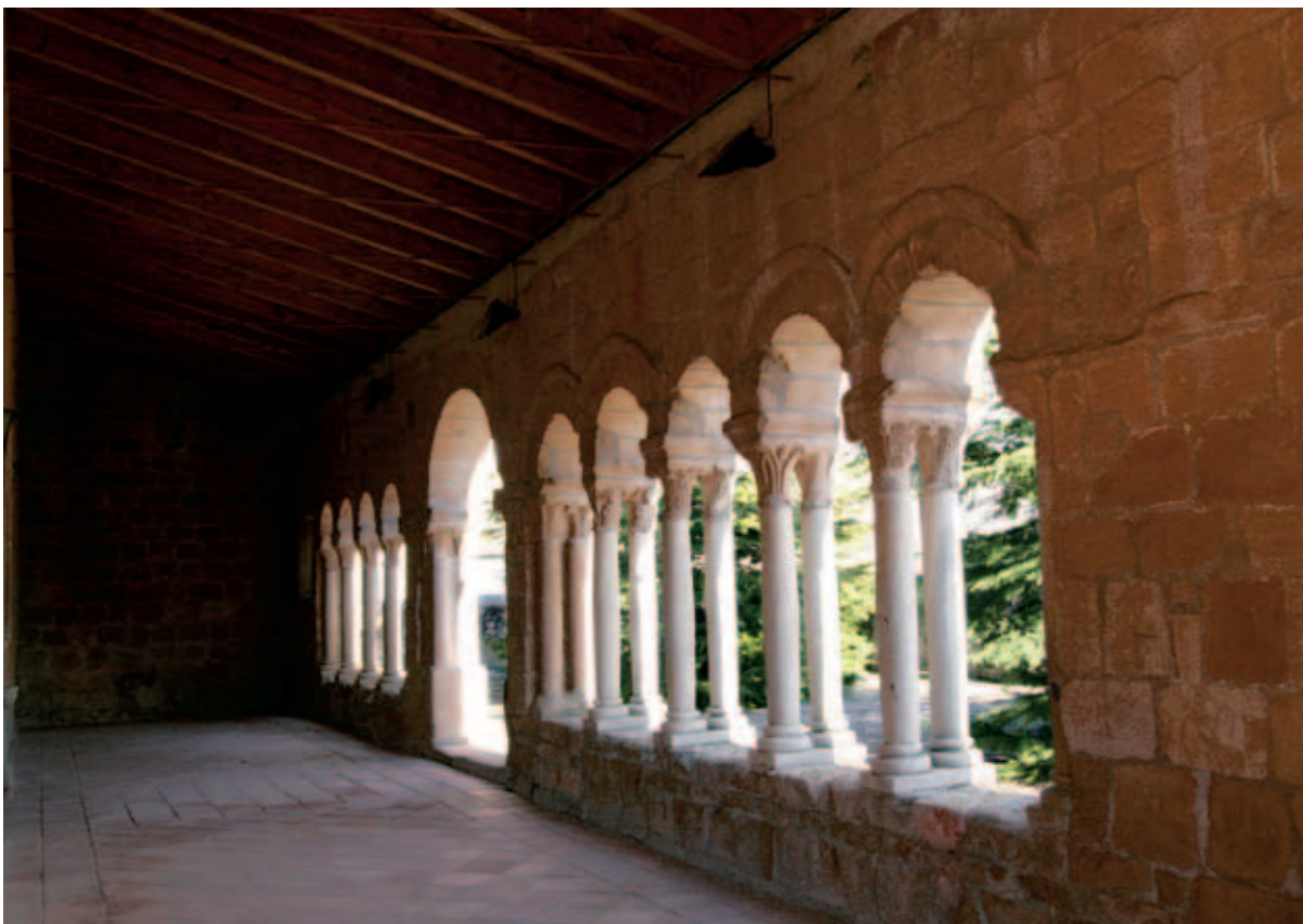
Interior del pórtico
