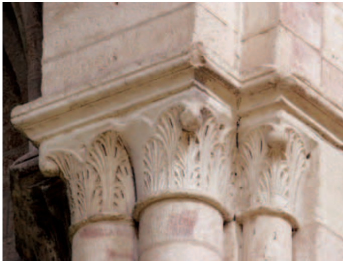
Capiteles de las naves
