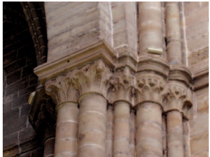
Capiteles de las naves
