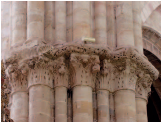
Capiteles de las naves
