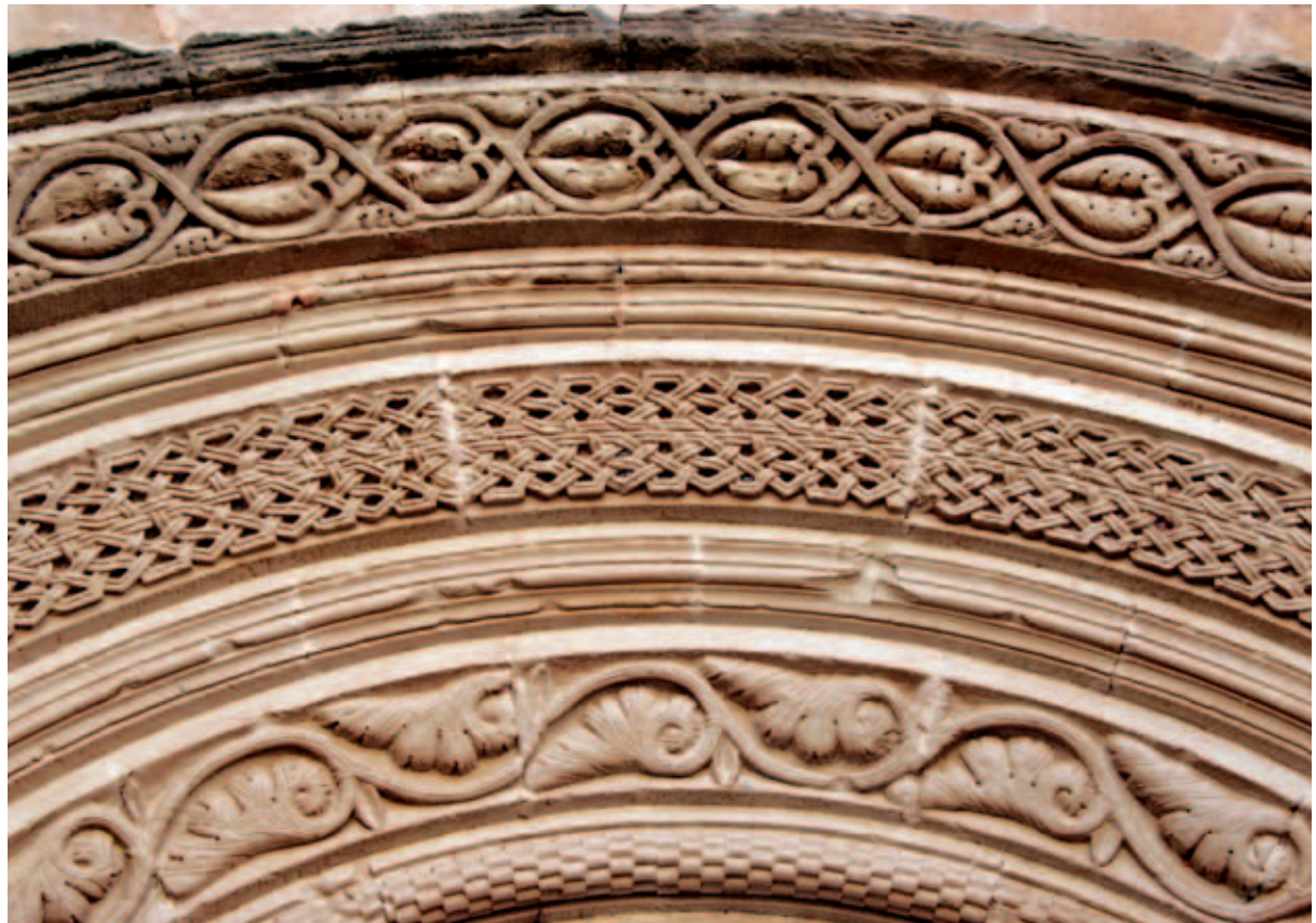
Fachada occidental. Detalle de la portada del Evangelio
