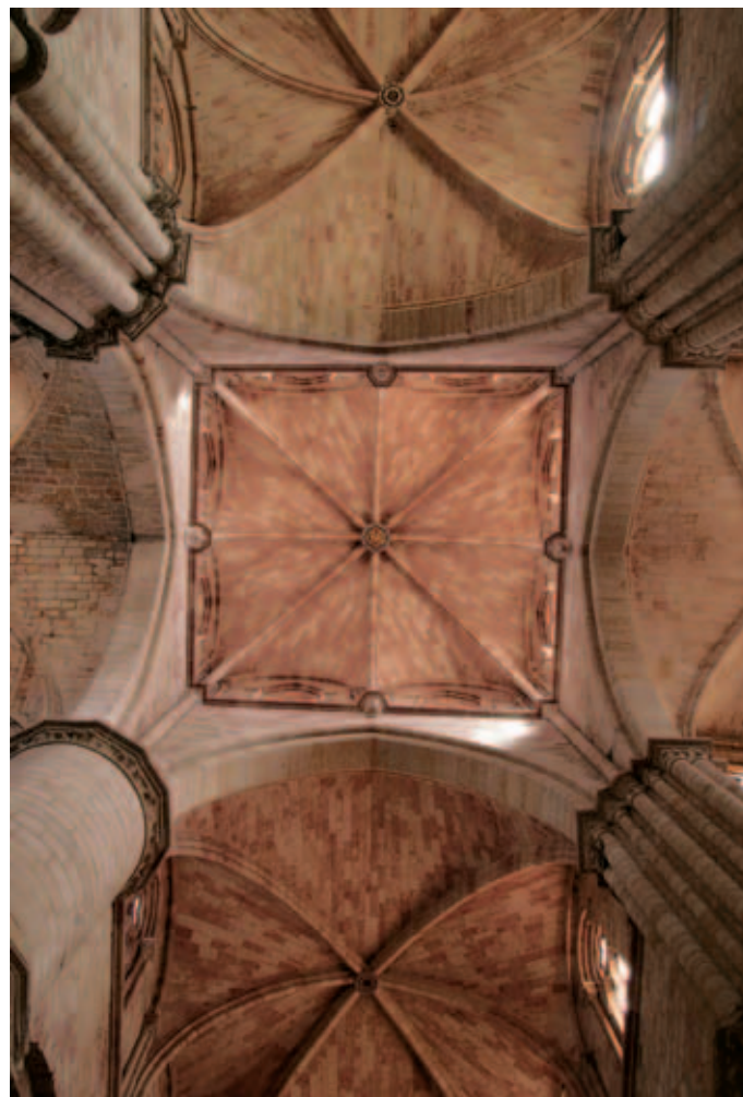
Bóveda del cimborrio
