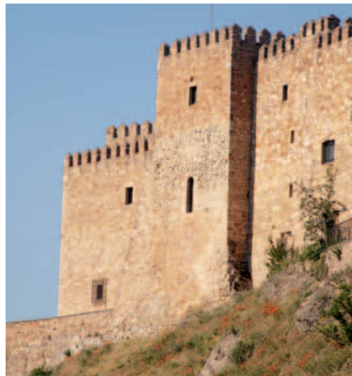
Muro este de la capilla
