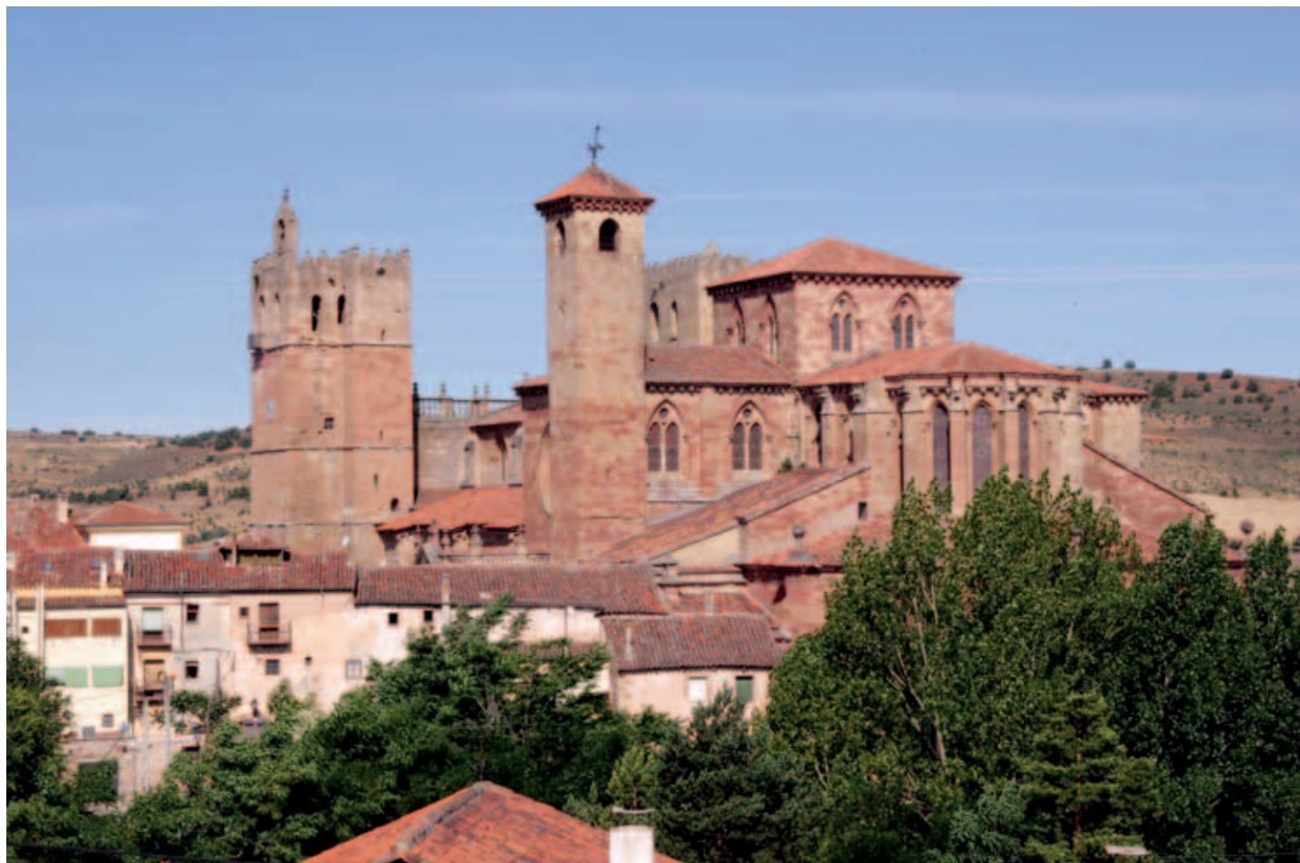
Vista desde el lado sureste
