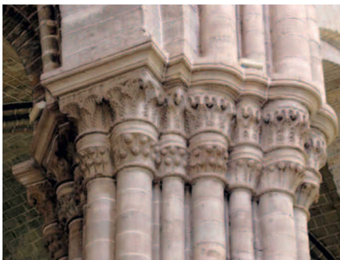
Capiteles de las naves
