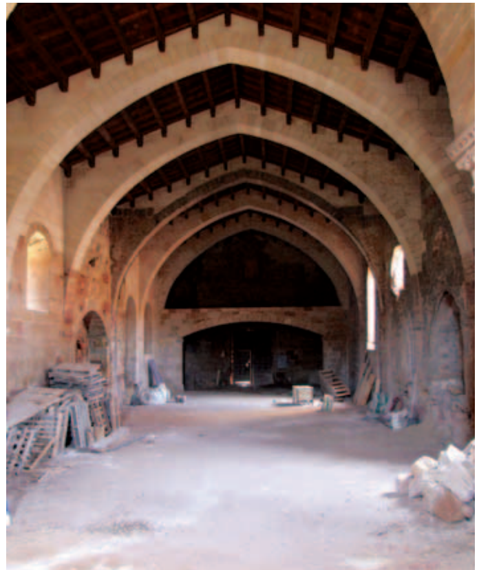
Interior de la nave
