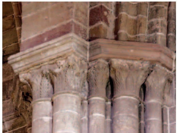
Capiteles de las naves
