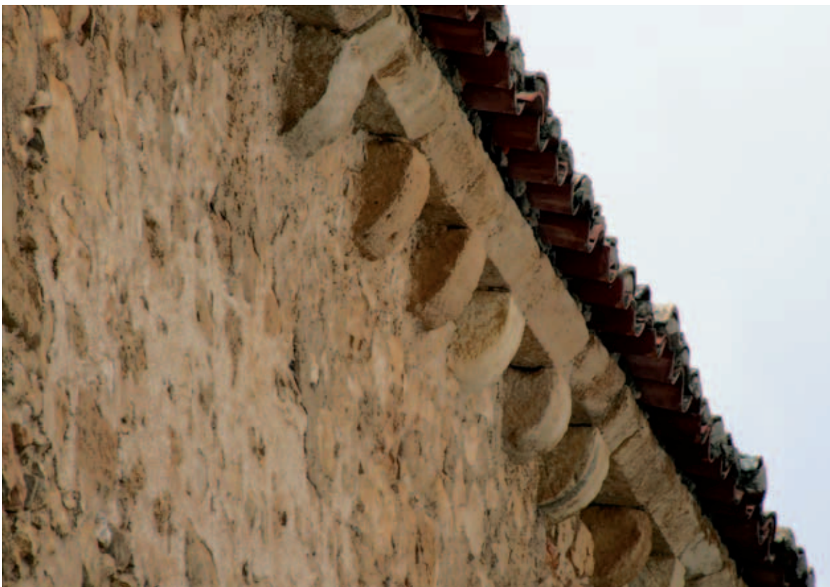
Exterior. Detalle de canecillos del muro norte
