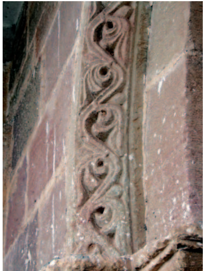
Detalle de la arquivolta de la portada sur
