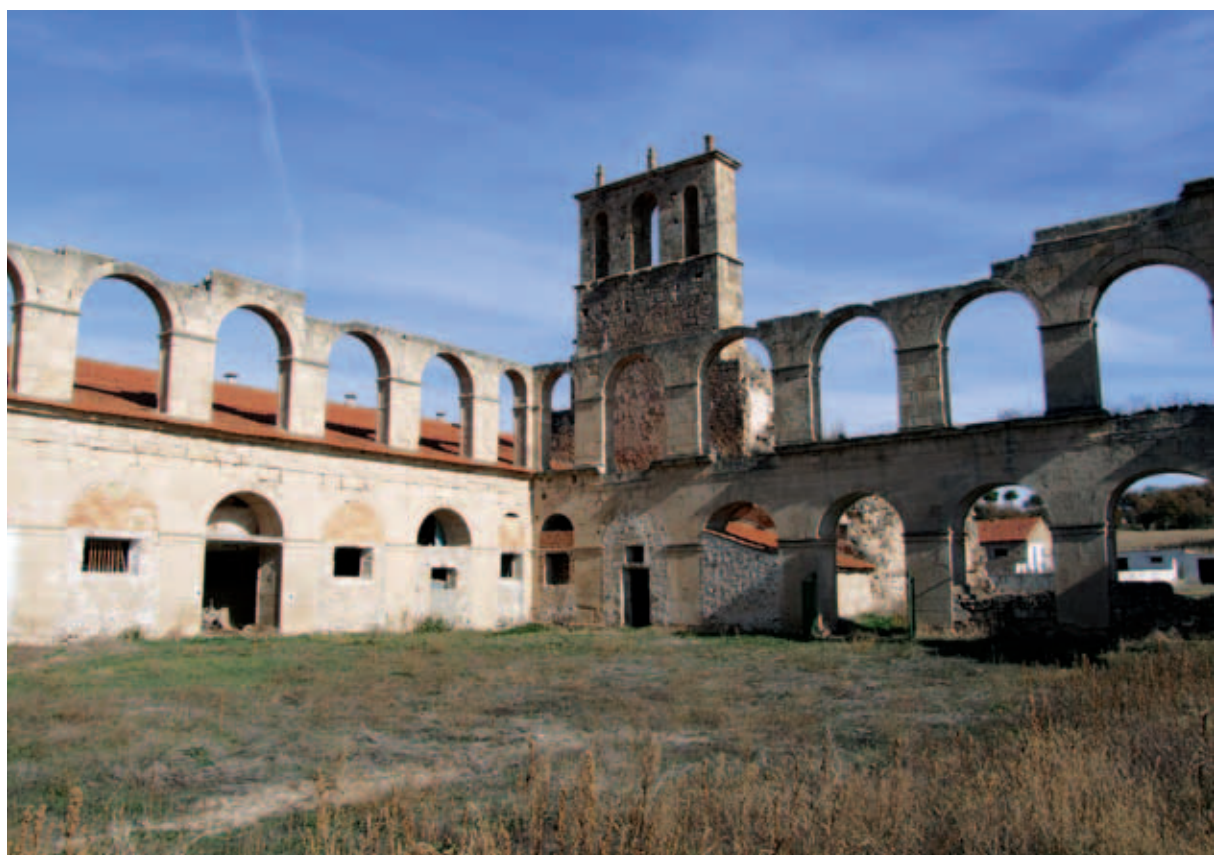
Galerías oriental y septentrional del claustro
