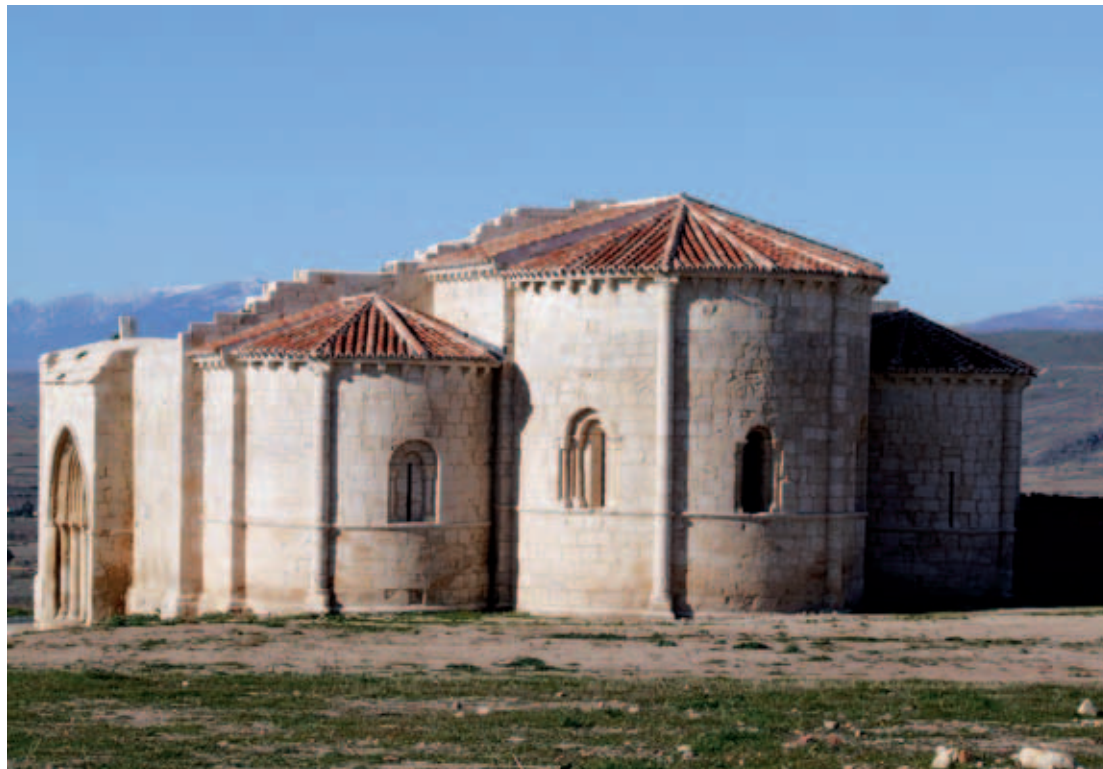
Vista desde el lado sureste
