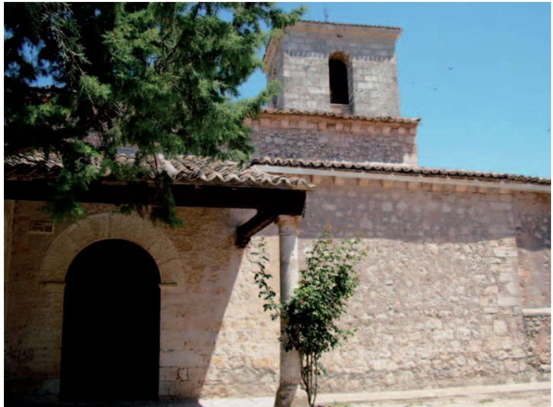
Vista del muro sur
