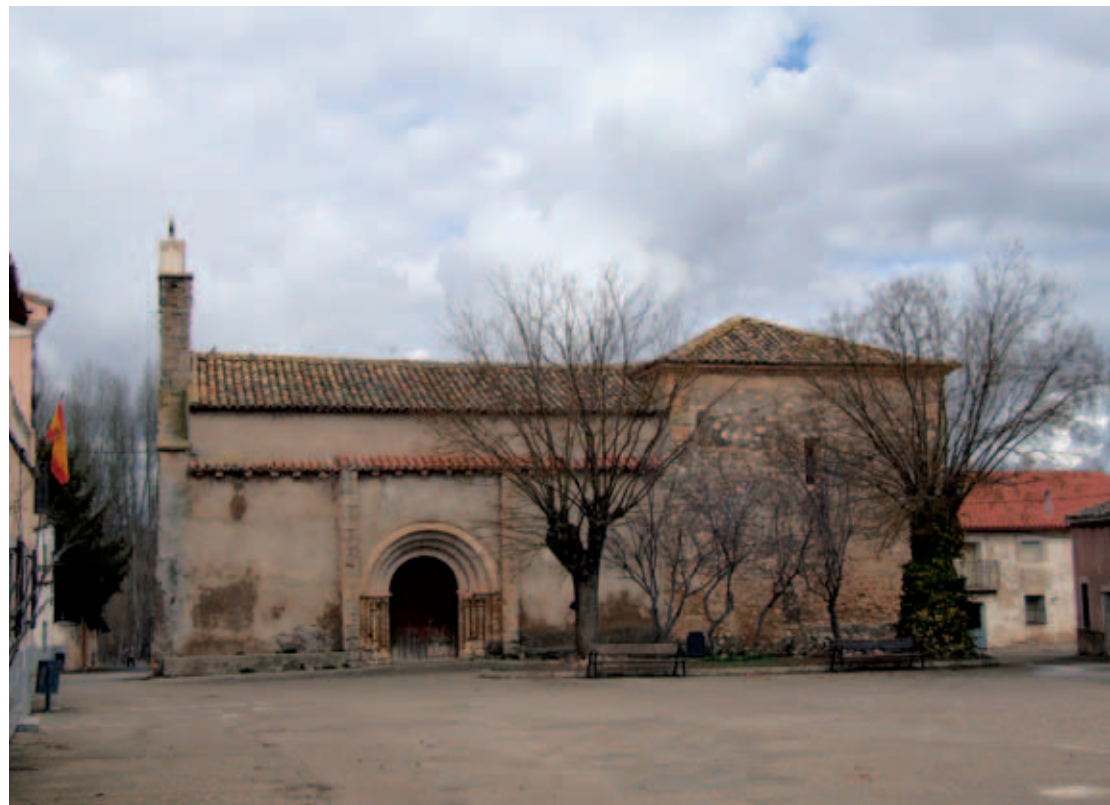
Vista del templo desde el lado sur
