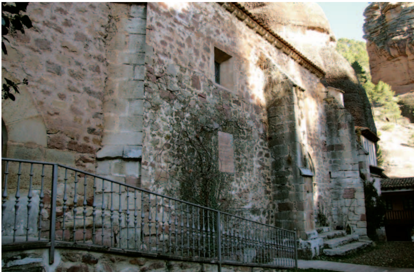
Vista lateral del muro sur
