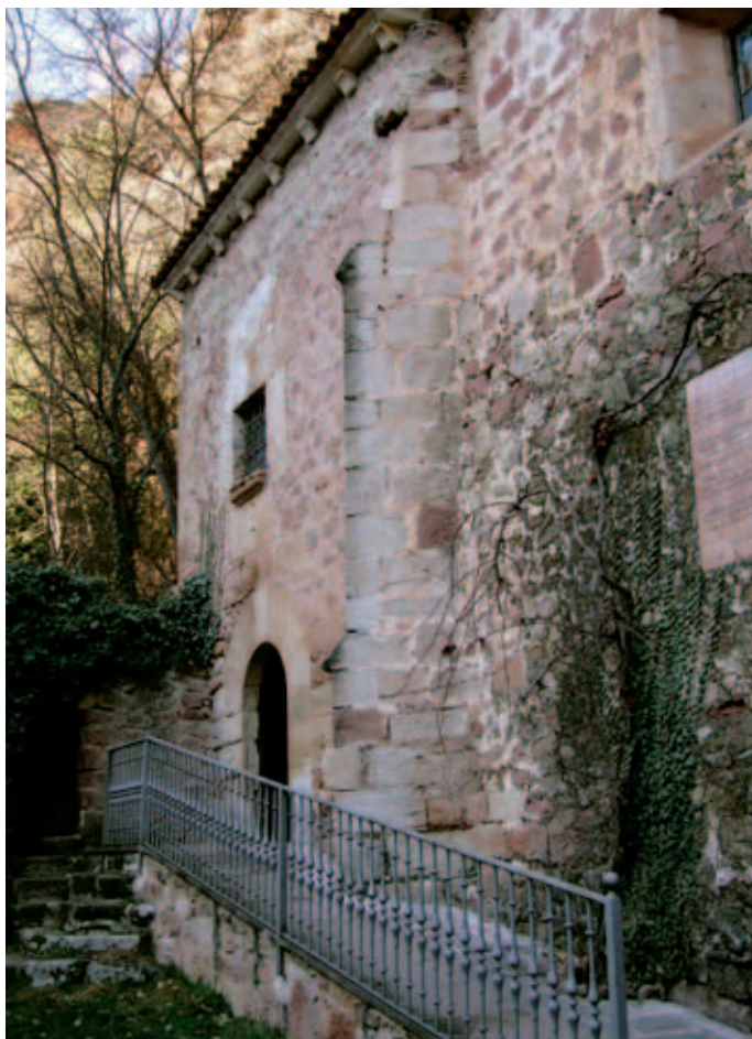
Detalle del muro sur
