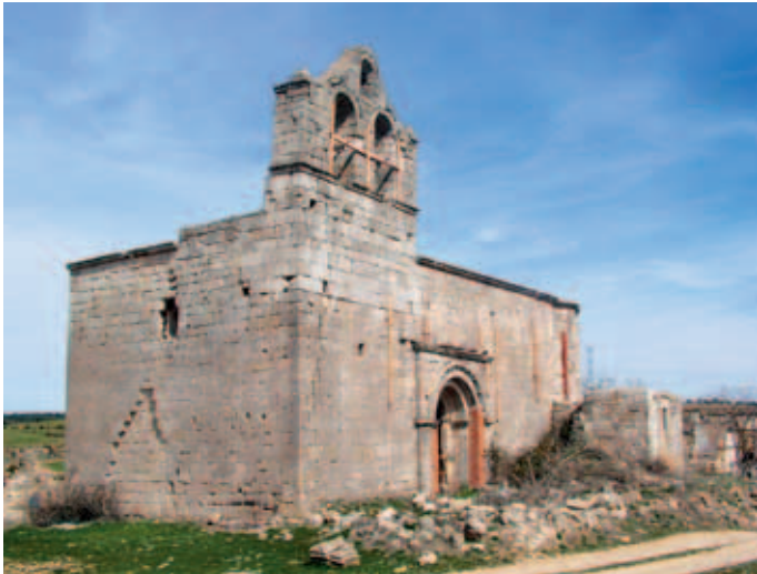
Vista exterior desde el lado suroeste
