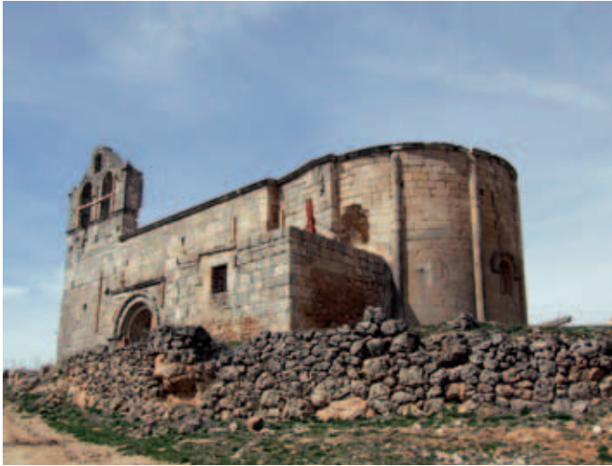
Vista exterior desde el lado sureste
