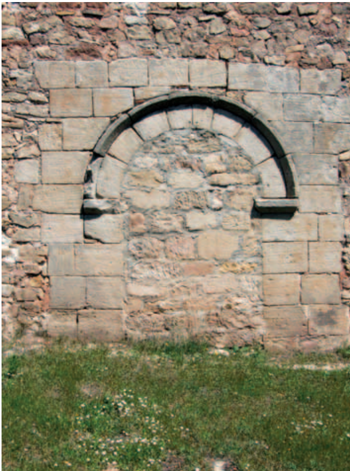
Portada cegada en el muro sur
