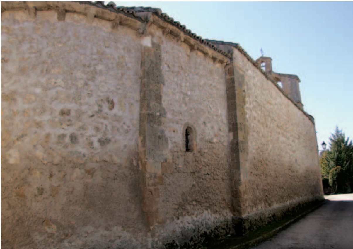
Vista del muro norte
