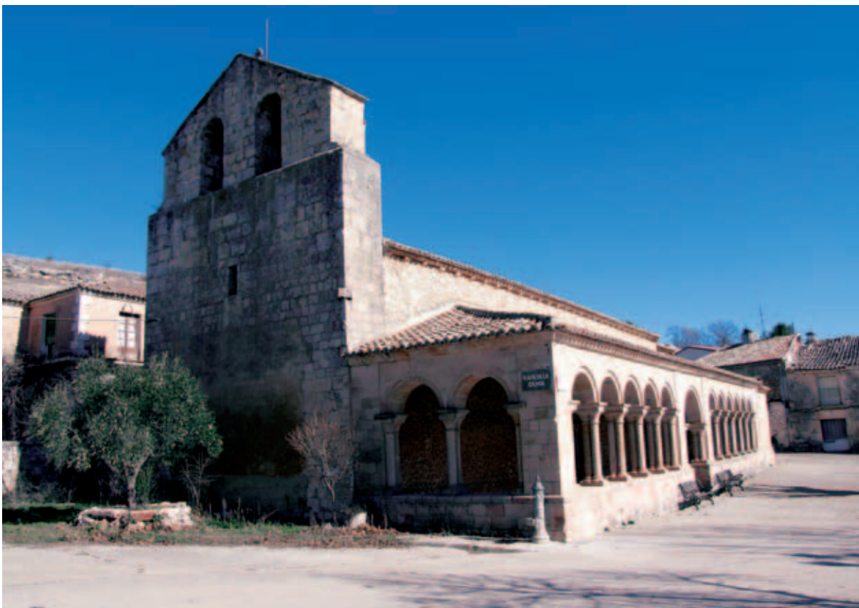
Vista desde el lado suroeste
