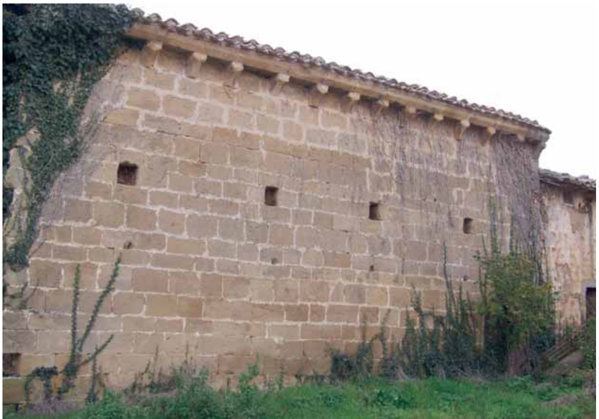
Muro norte con caneillos
