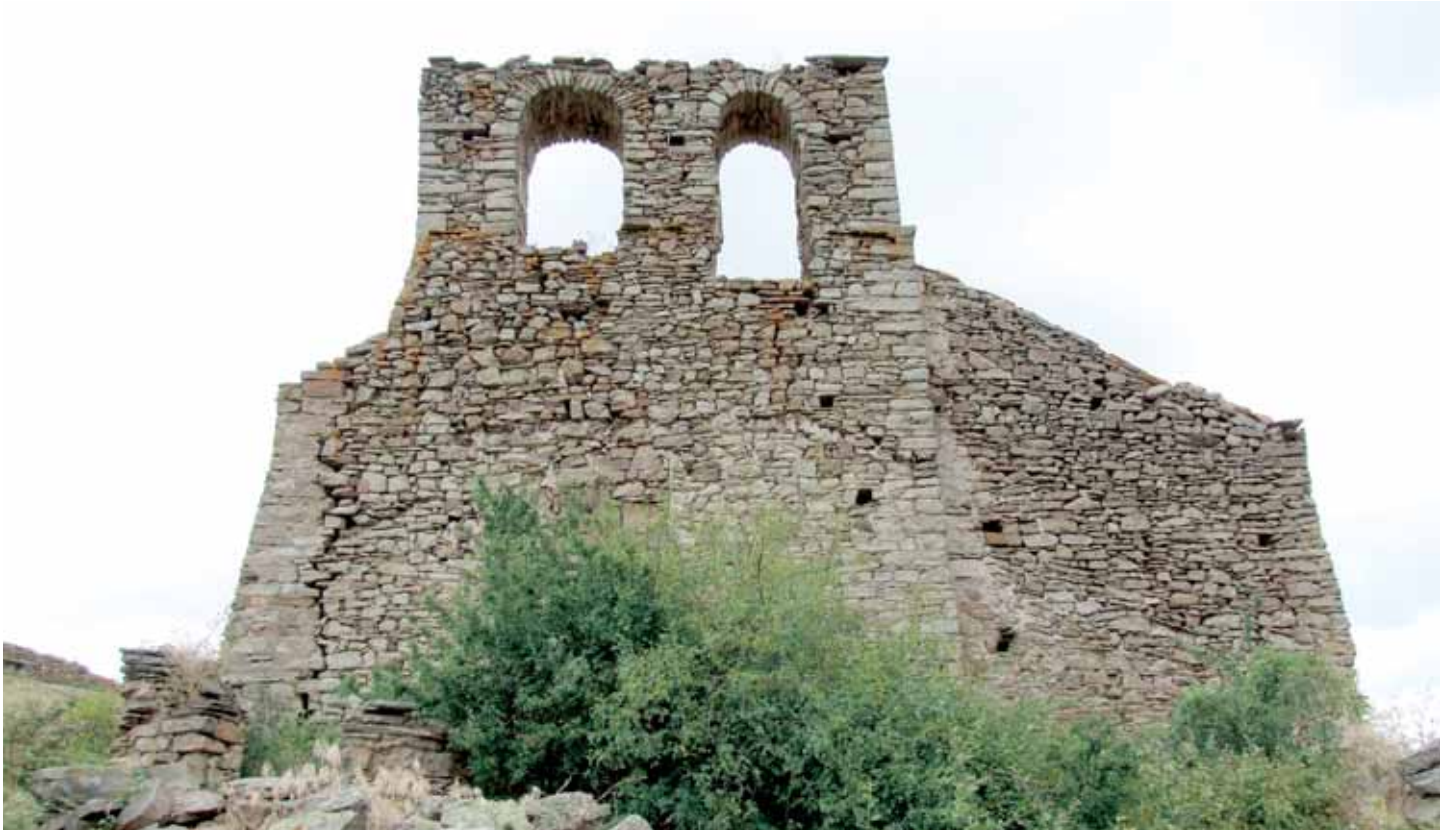
Muro oeste. Espadaña
