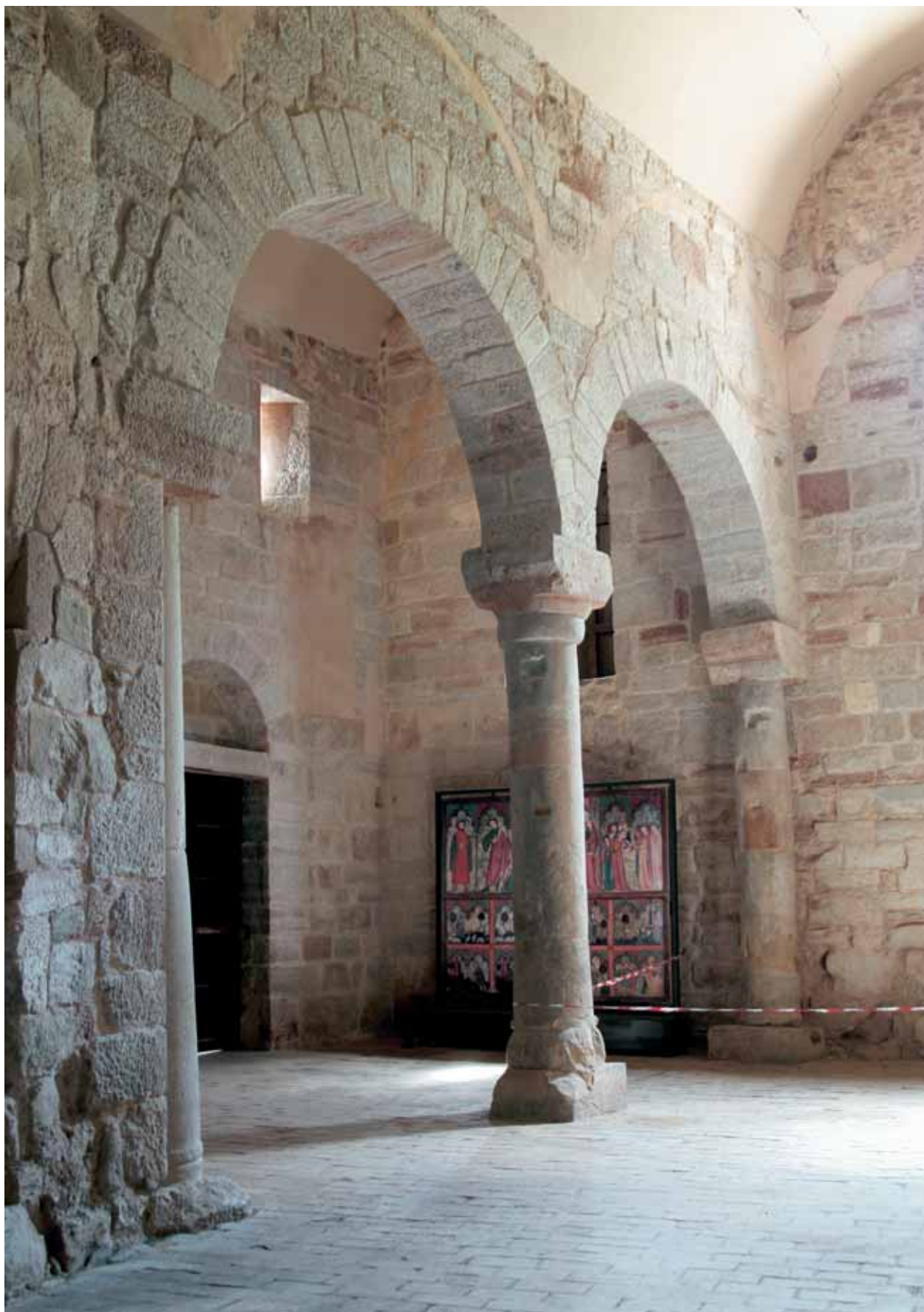
Ampliación románica de la iglesia
