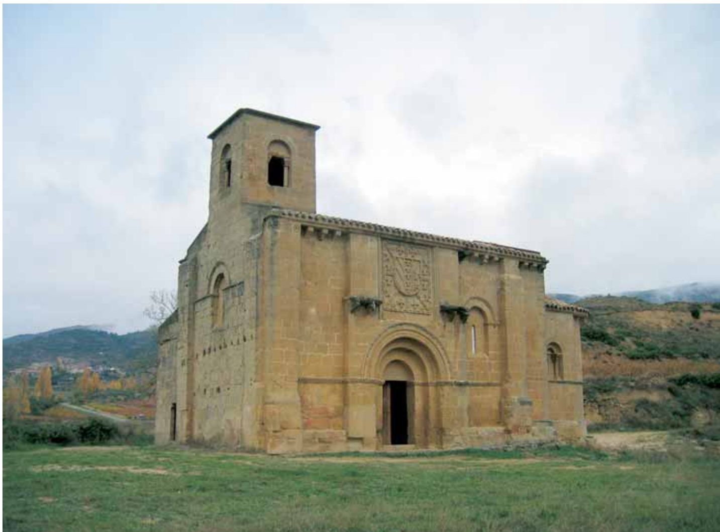
Exterior desde el Suroeste
