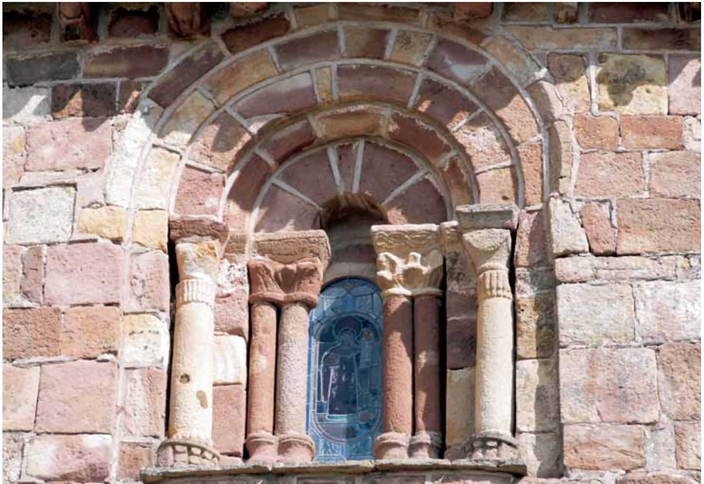
Ventana muro oeste
