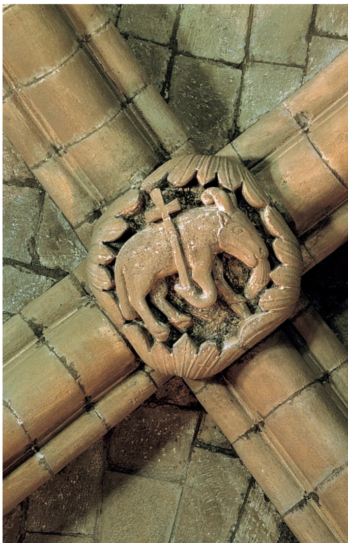
Clave de la bóveda del presbiterio
