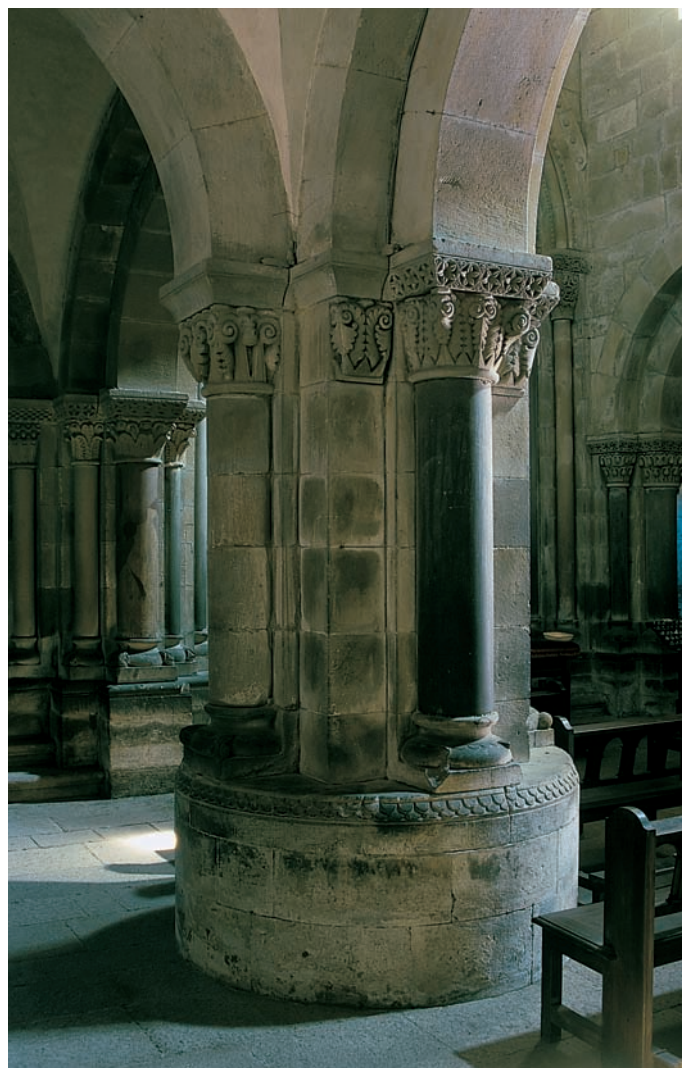
Pilar de la nave
