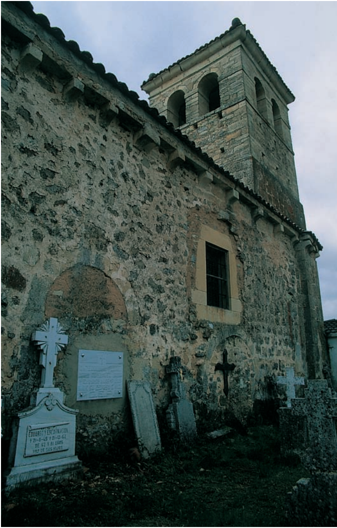
Muro septentrional de la nave
