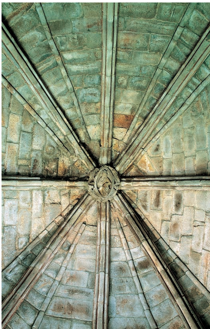
Bóveda de la antecámara
