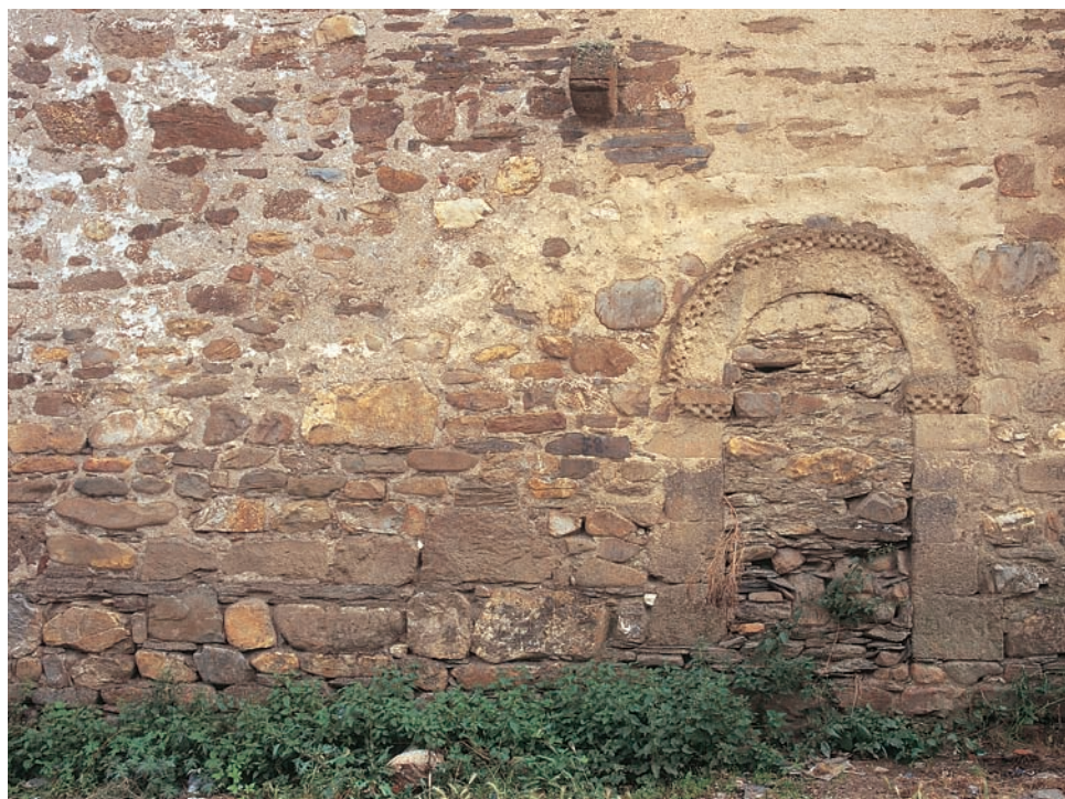
Portada cegada en el muro del evangelio
