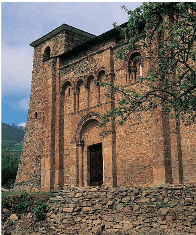
Muro meridional del templo
