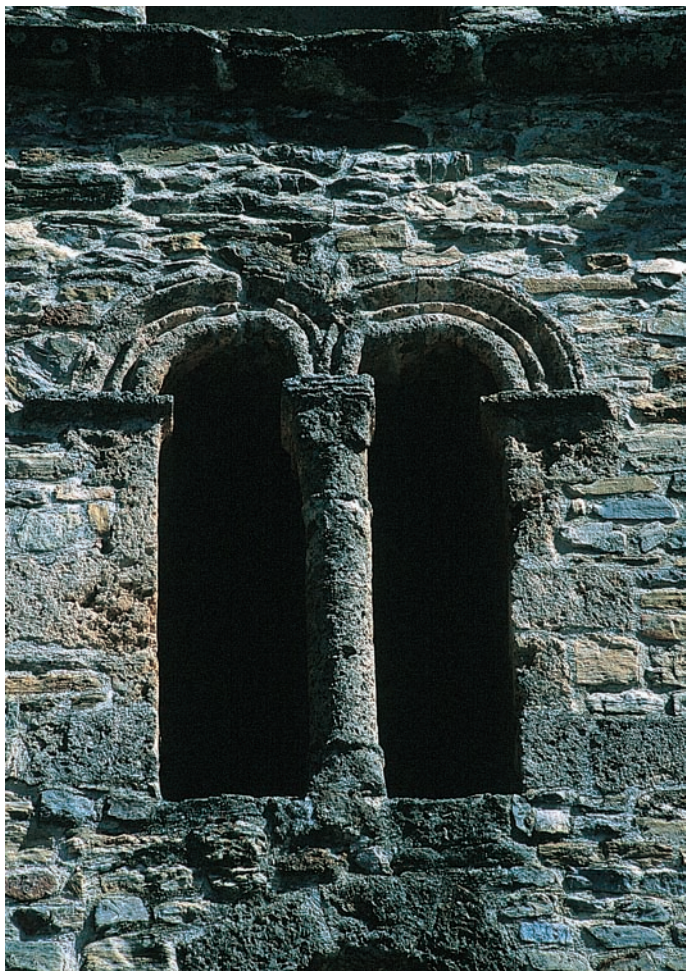
Ventanal de la torre
