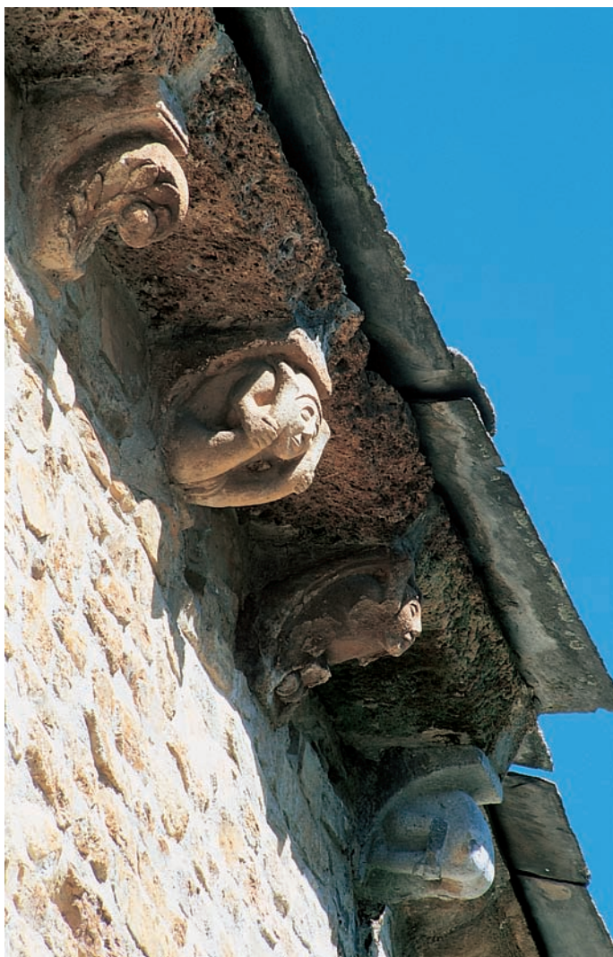
Canecillos del muro sur
