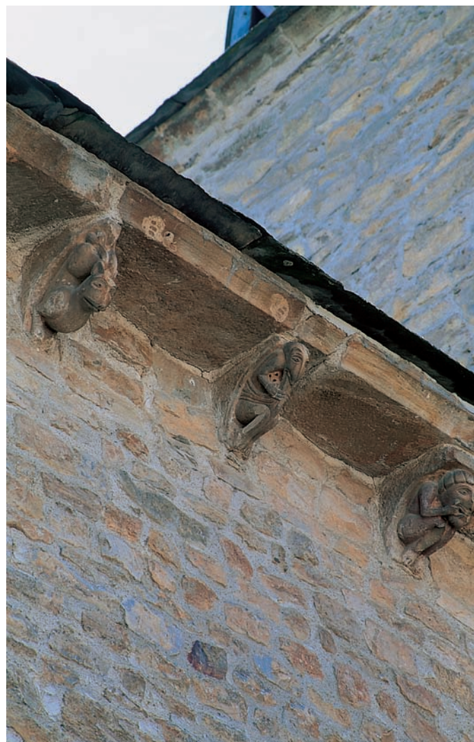
Canecillos del muro norte
