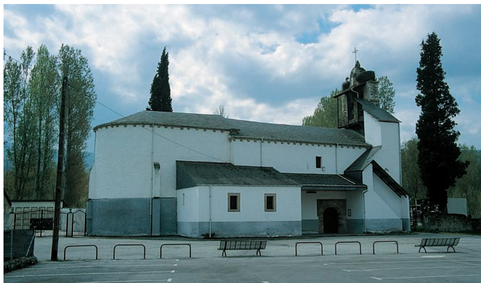
Vista general del edificio
