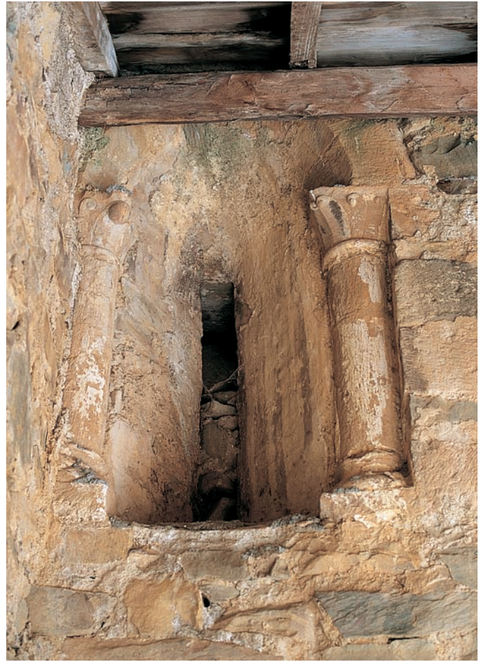
Ventana en el muro sur
