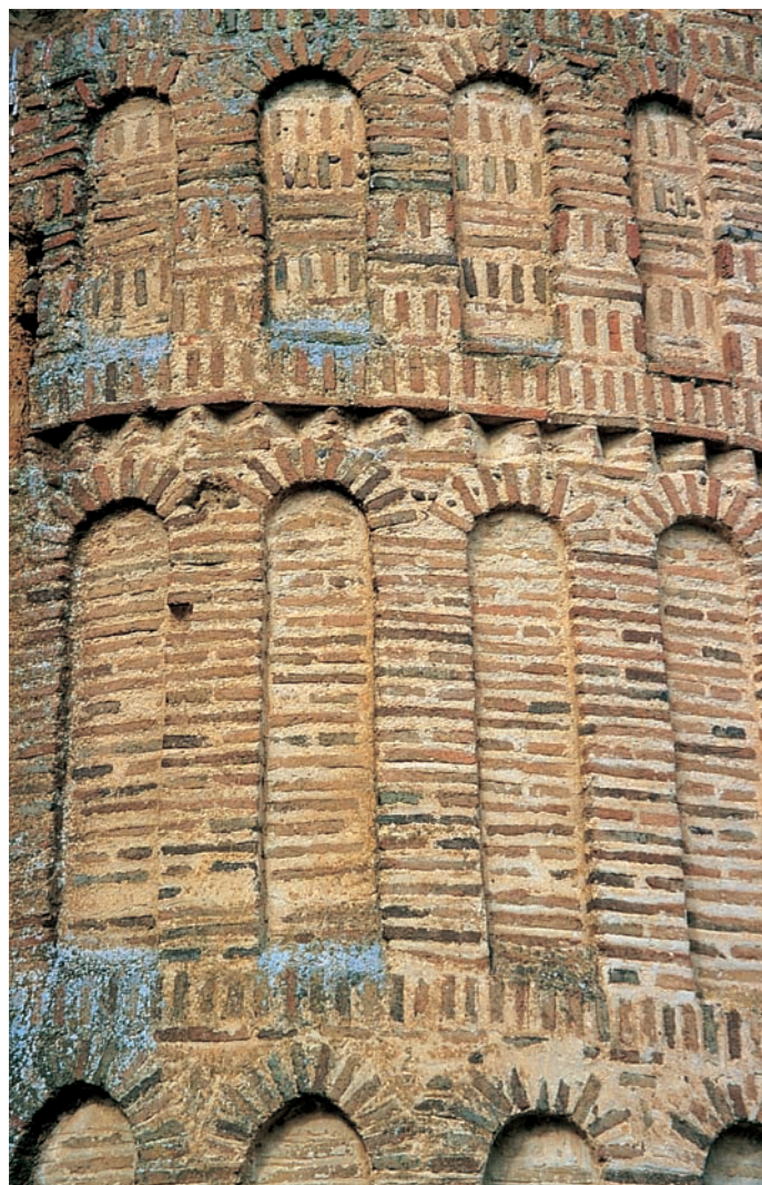
Detalle de los ábsides
