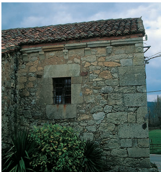
Muro meridional de la cabecera
