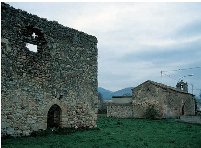
Ruinas del priorato de Valdediós y la iglesia al fondo
