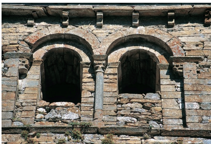
Detalle de la torre
