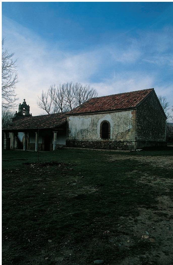
Vista general de la ermita
