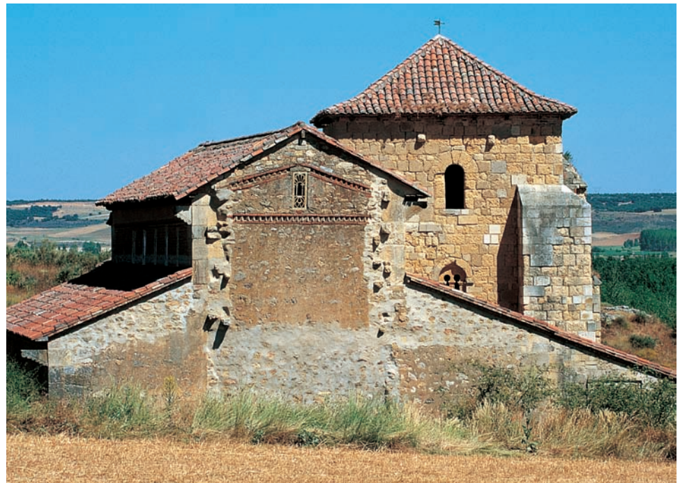
El edificio desde el oeste
