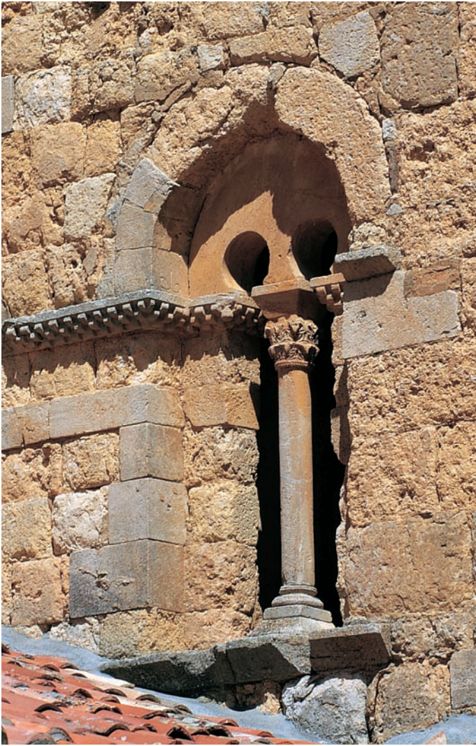
Ventana de la torre
