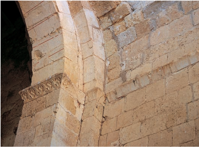
Arranque de la bóveda e imposta
