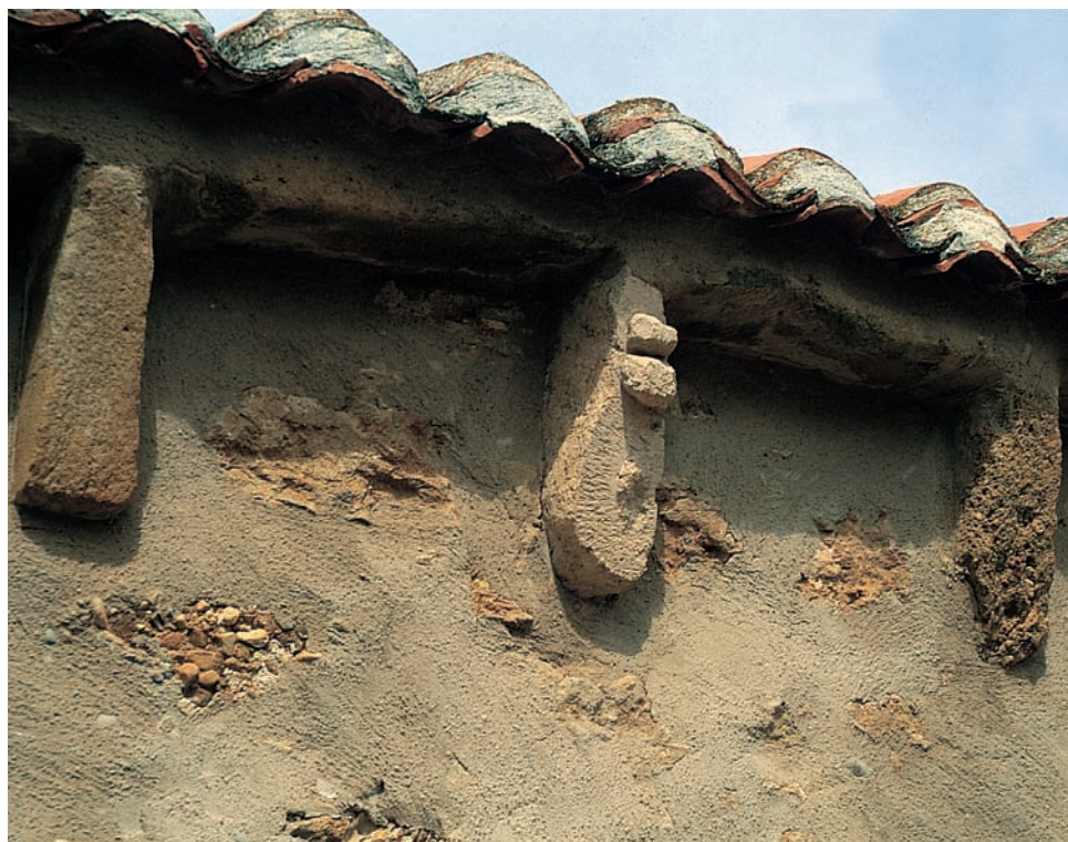
Canecillos del muro sur de la cabecera
