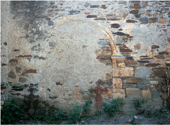
Portada cegada en el muro norte
