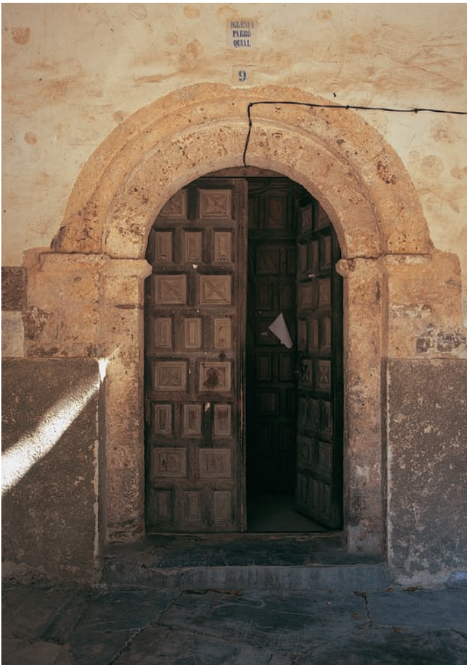
Portada principal, en el muro sur
