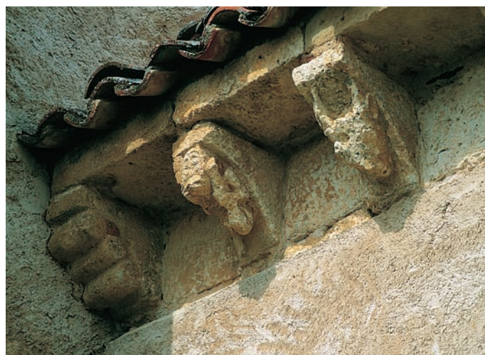
Canecillos del muro sur del ábside
