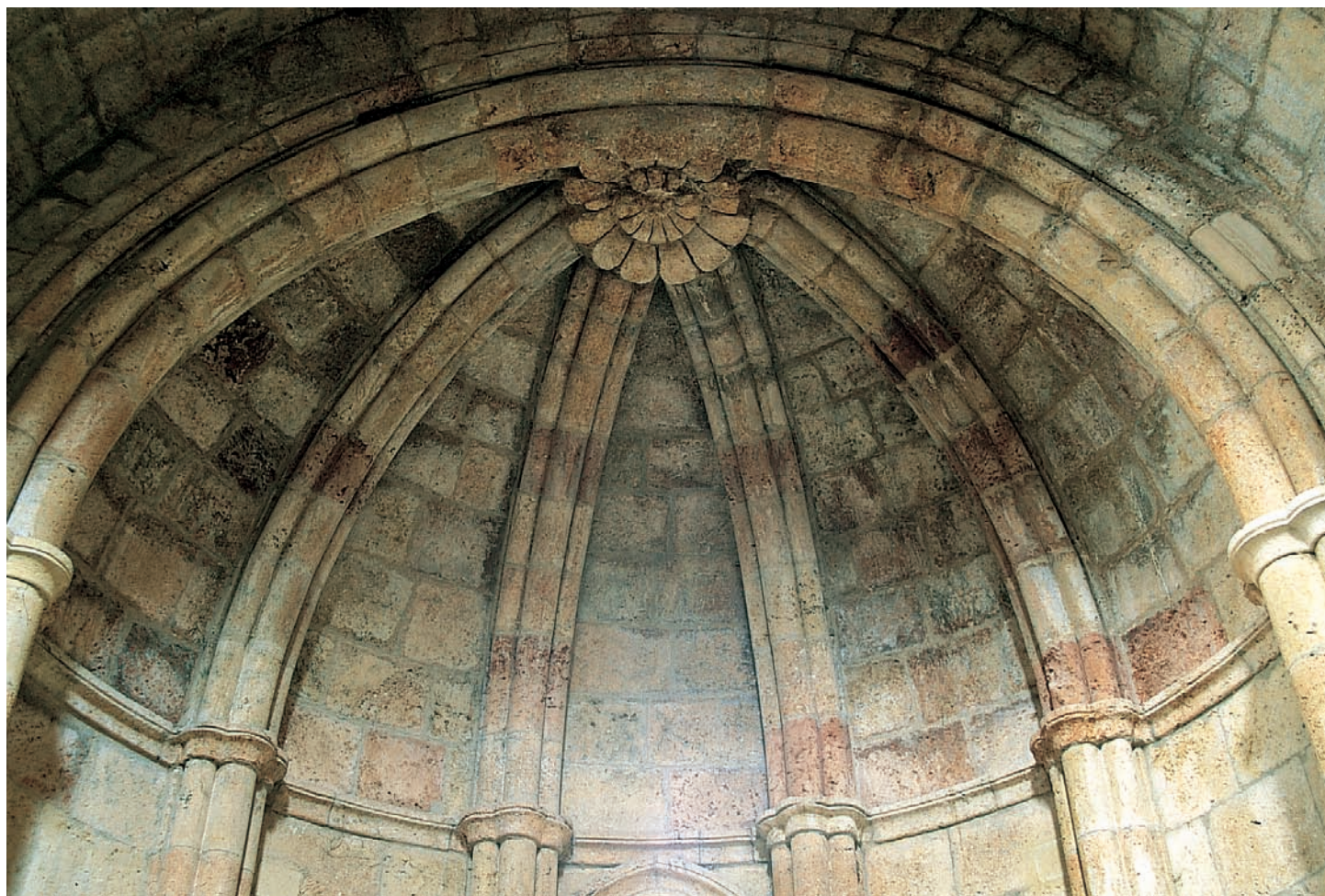
Bóveda de la capilla norte
