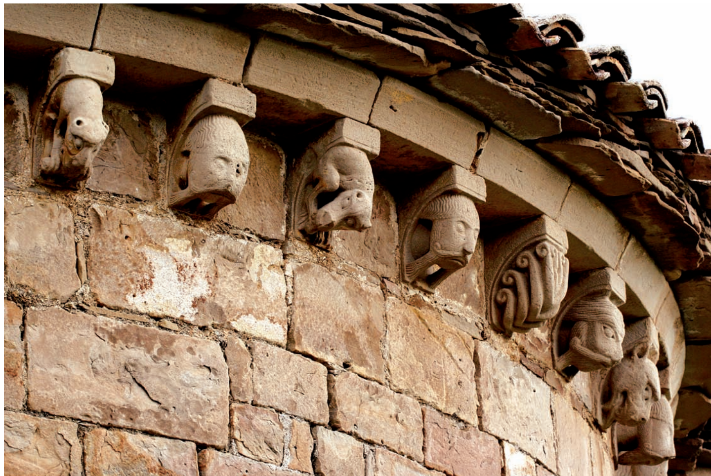
Detalle del ábside de Villaveta
