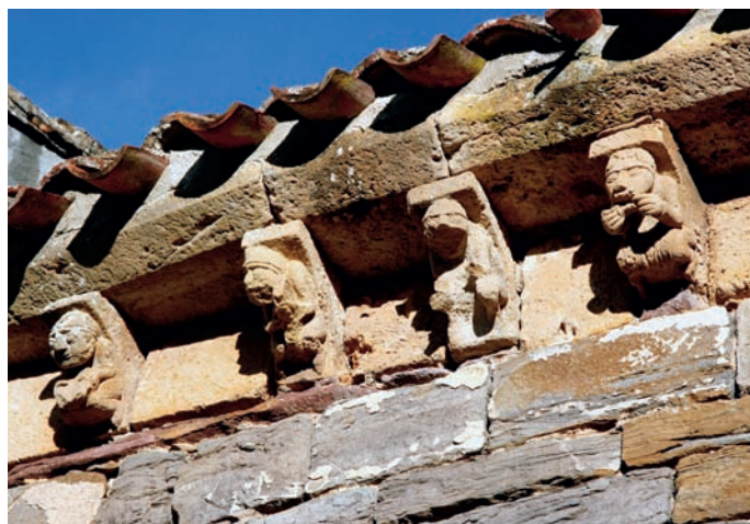
Canecillos del muro sur
