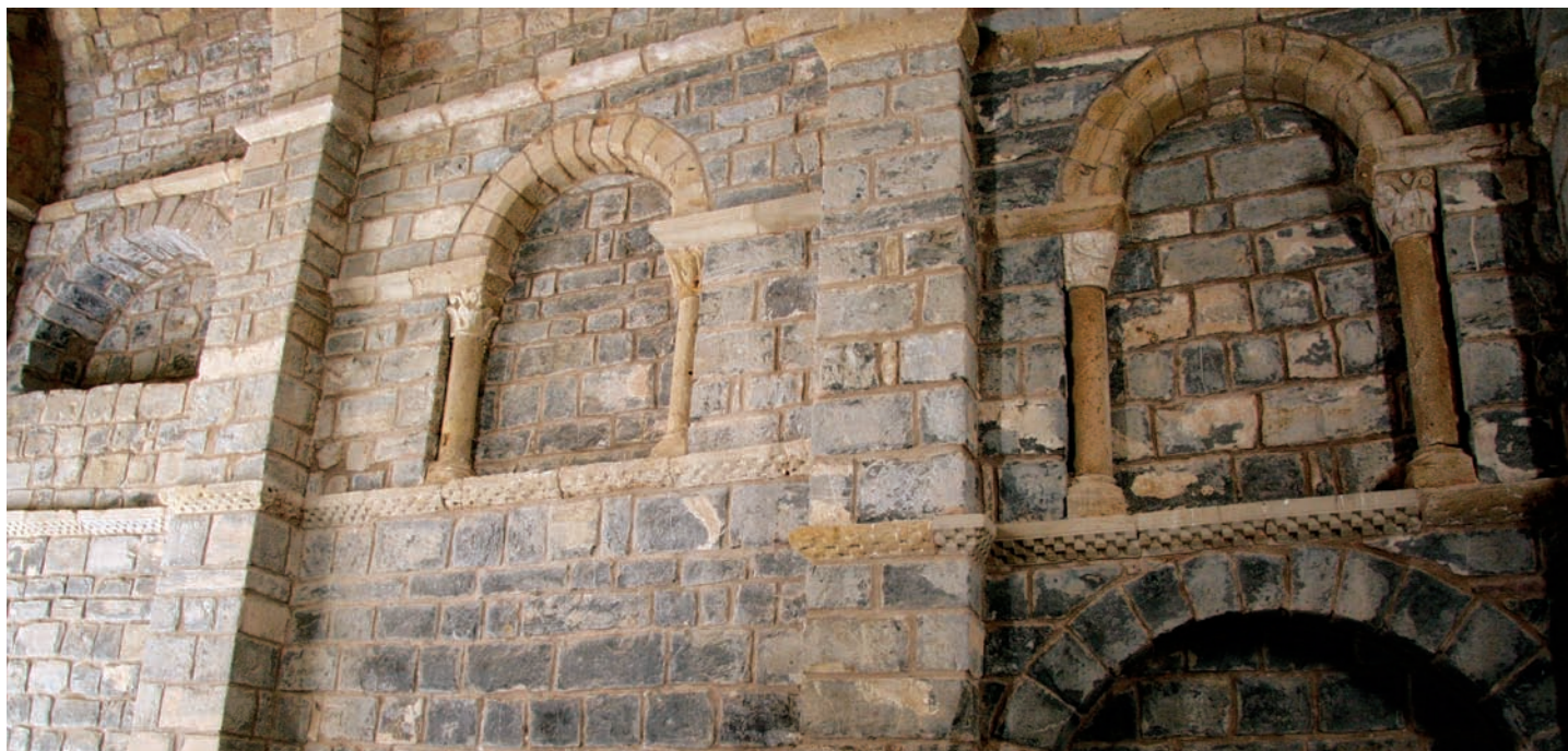
Interior. Muro norte
