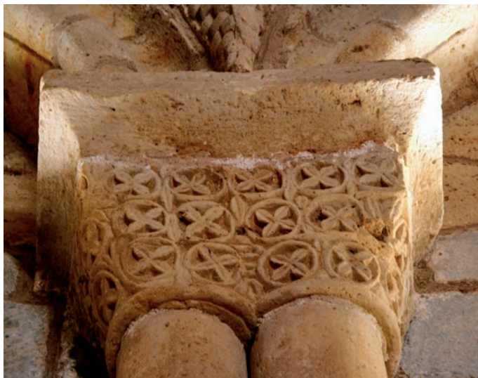
Capiteles del interior del ábside
