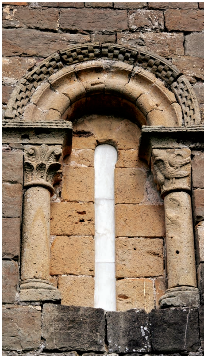
Ventana del muro sur
