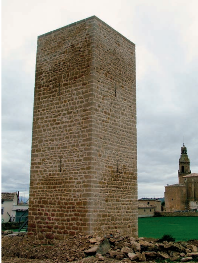
Vista general de la torre (flancos este y norte)
