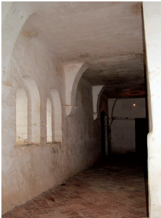
Interior del pórtico
