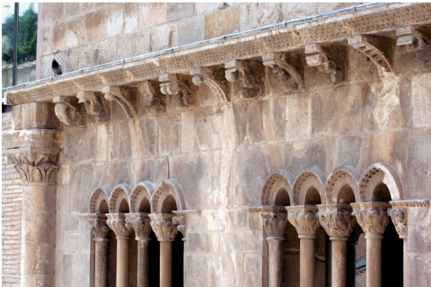
Conjunto de canecillos y ventanas
