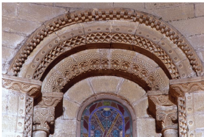
Ventana de la capilla mayor
