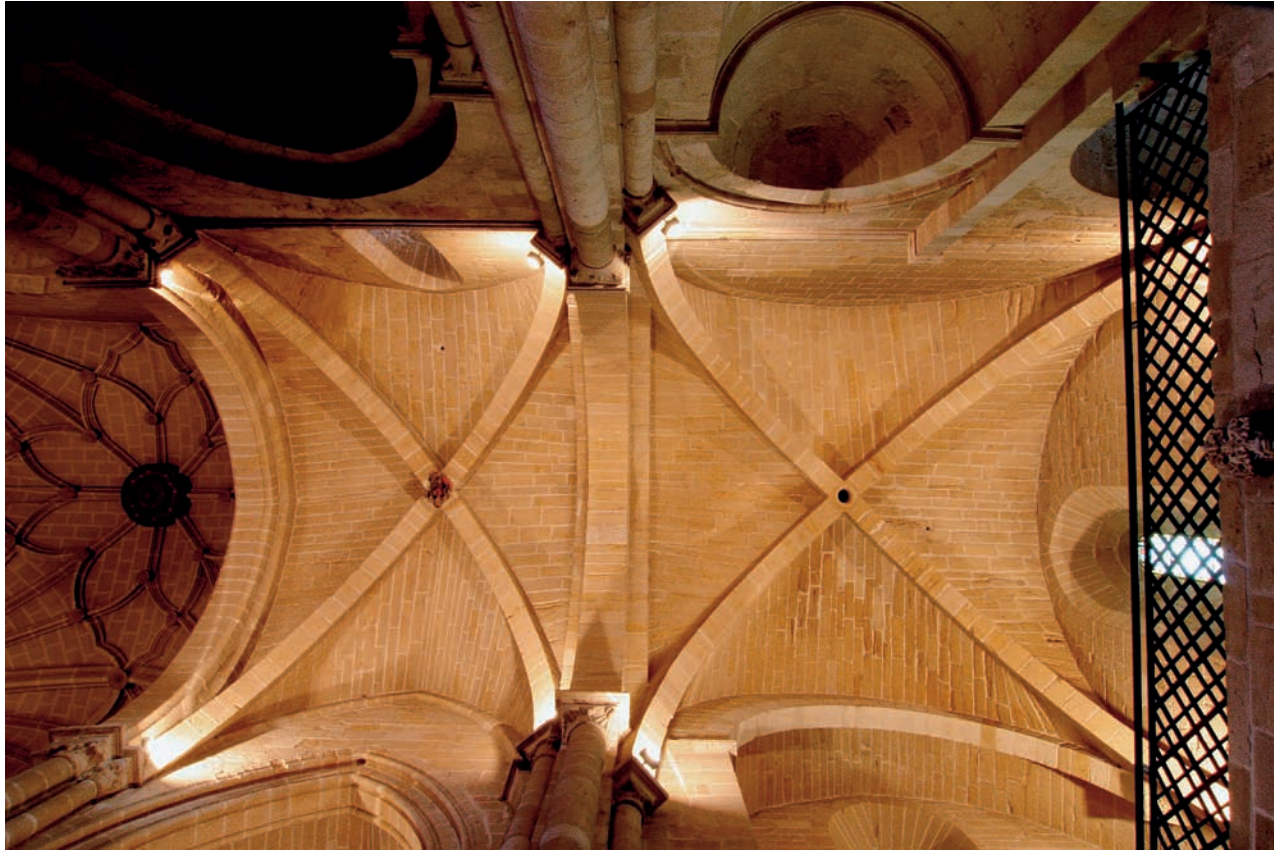
Bóveda del transepto norte
