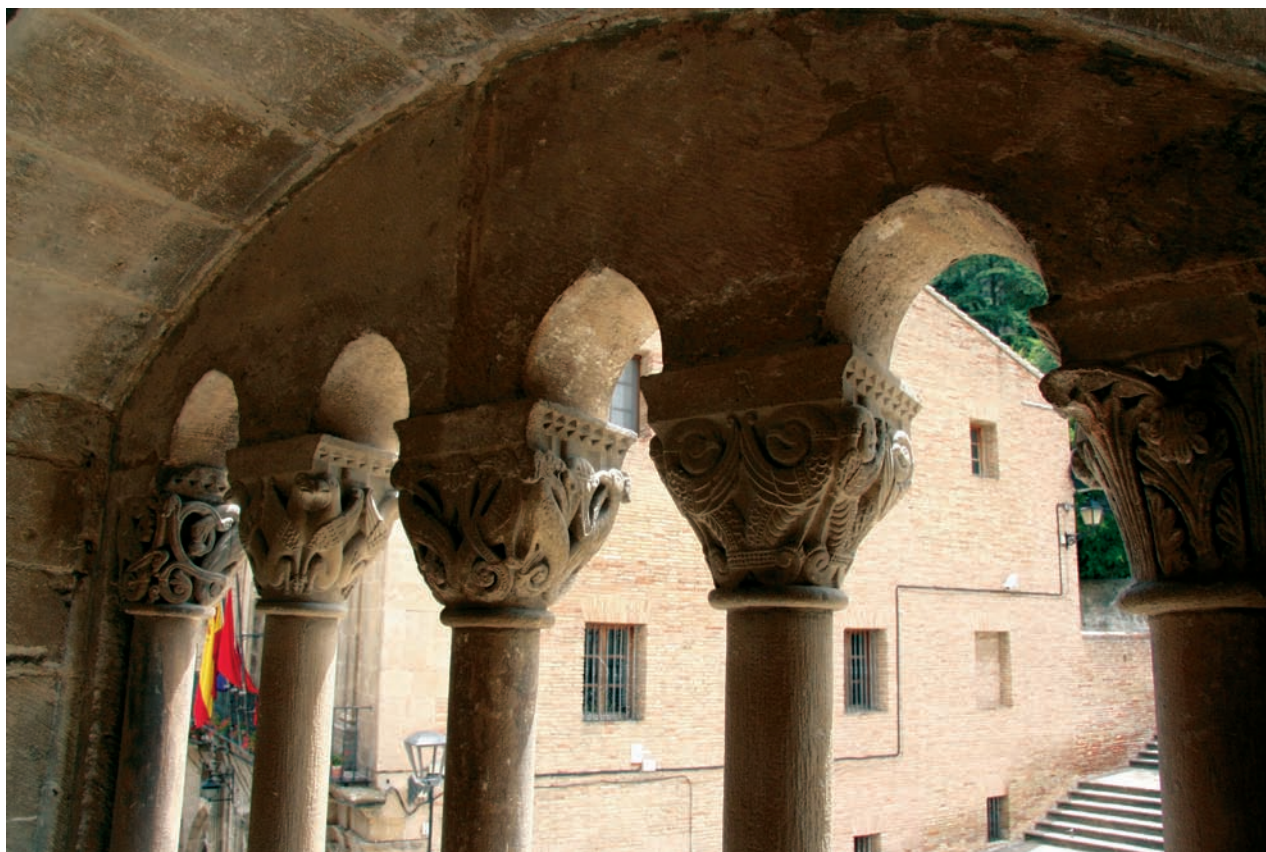
Detalle de un ventanal desde el interior
