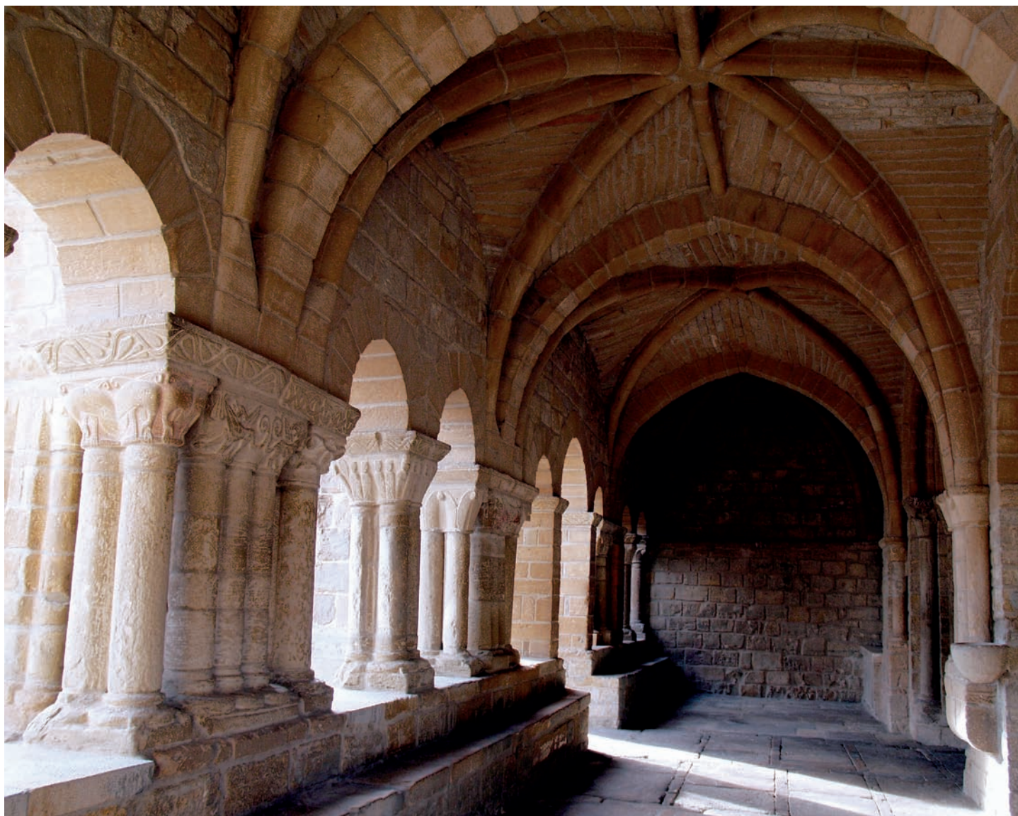
Interior del pórtico
