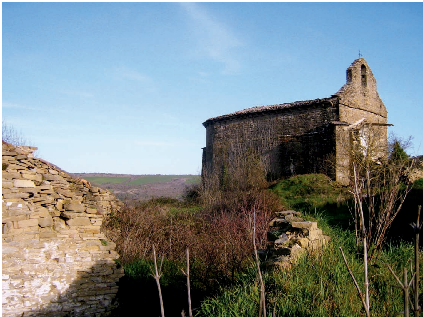
Panorámica desde el lado norte
