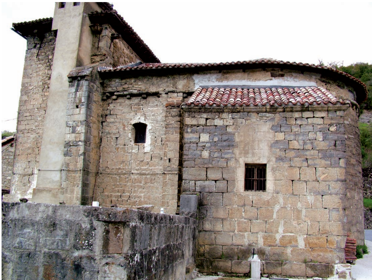
Vista desde el lado sur
